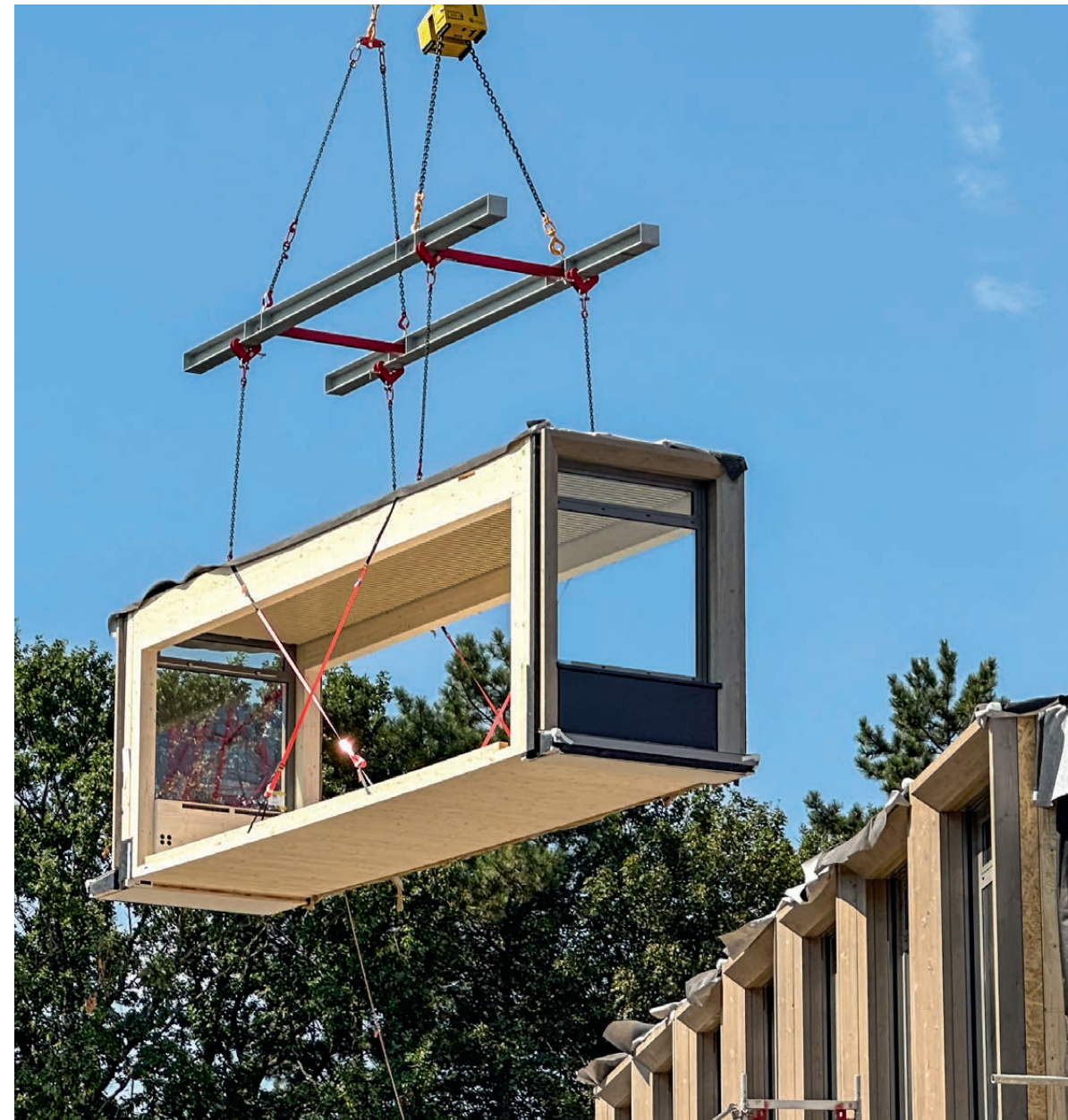
Fliegende Büroräume über Stuttgart: Aus 286 Holzeinbaumodulen entstand das „ZERO“ in Stuttgart.
