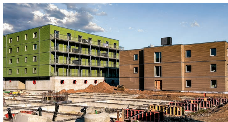
Für die serielle Holzbaumweise beim „Kleehof“ beschleunigte das eigens entwickelte Konzept „Flat“ den Bau.
