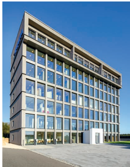
Deutschlands erster Holzbau mit acht Vollgeschossen, dessen tragende Konstruktion aus Massivholz besteht: KAMPA zeigt mit K8 moderne und nachhaltige Bauinnovation.
