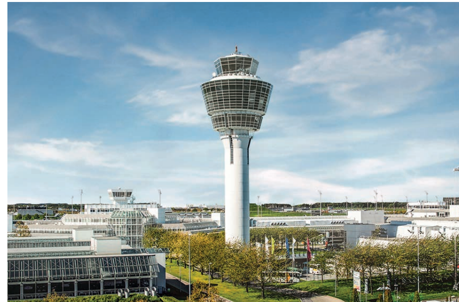
Um Netto-Null-Emissionen zu erreichen, setzt der Flughafen München Maßnahmen in den Bereichen Energieversorgung, Immobilien, Fuhrpark und bei den flughafentechnischen Anlagen um.
