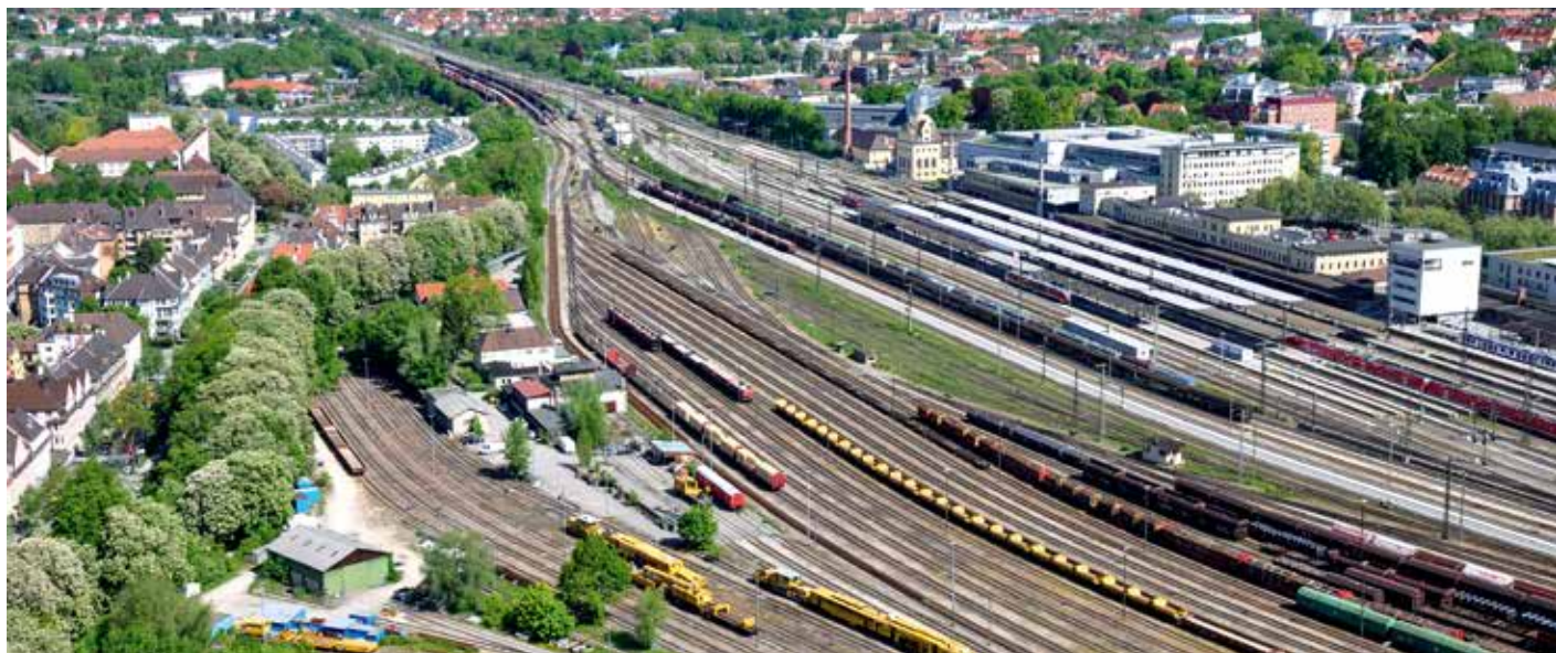
Der Güterverkehr muss in Zukunft stärker als bisher von der Straße auf die Schiene verlagert werden (im Bild der Augsburger Bahnhof).
