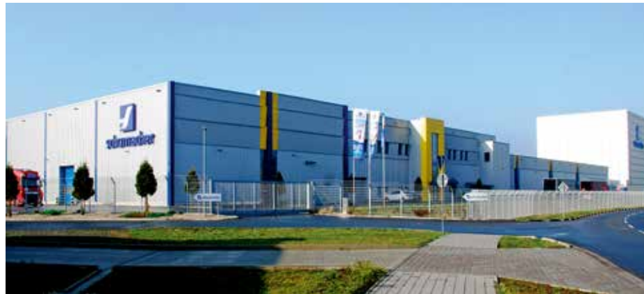
Neues Werk des Verpackungsherstellers Schumacher Packaging im AirportPark FMO
