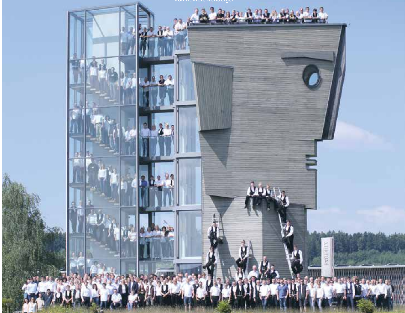
Der „Holzkopf“ an der Lindauer Autobahn bei Erkheim: Botschafter einer aufgeklärten Epoche
