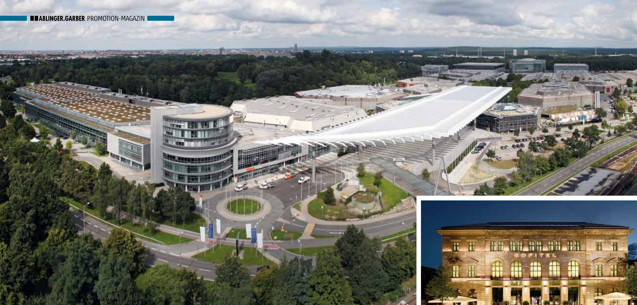
Beste Erreichbarkeit sichert den Tagungskonzepten in Bayern die hohe Frequenz. Das NürnbergConvention Center ist an Bahn und Flughafen direkt angebunden.
