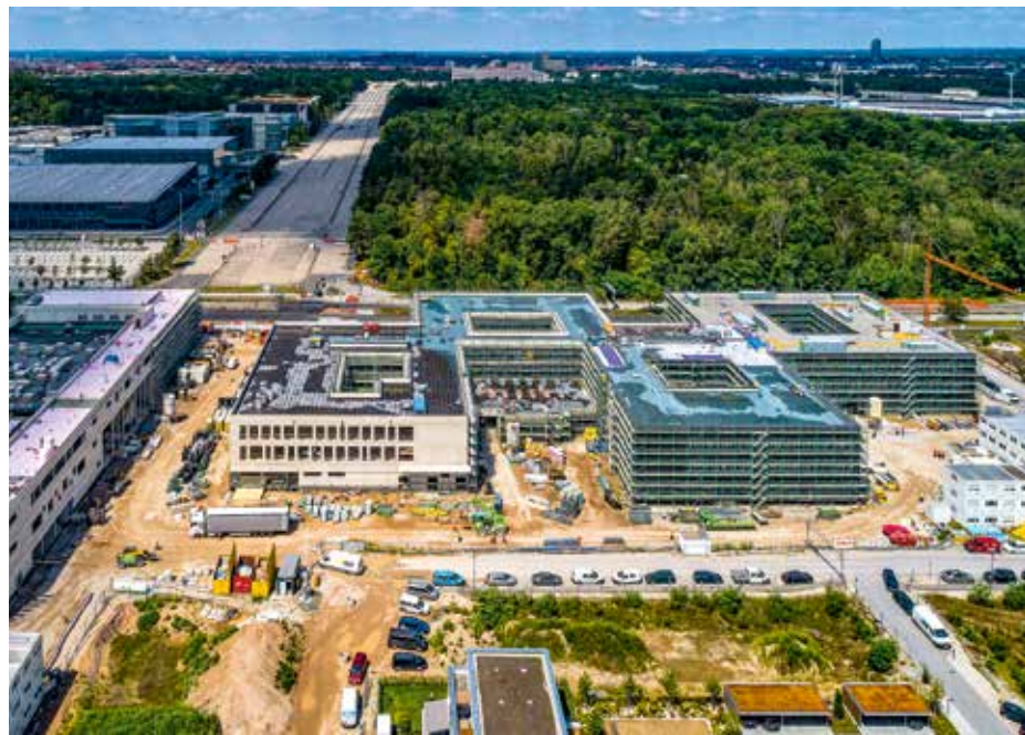
Der dreigeschossige Neubau umfasst vier Gebäudeteile mit rund 28 000 Quadratmeter und einen ca. 11 000 Quadratmeter großen Sporthallenkomplex.
