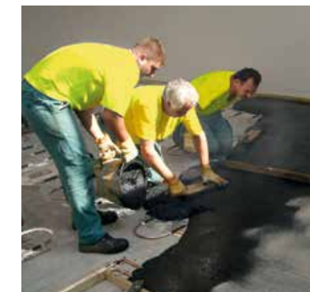
Die Mischung aus natürlichen Gesteinen und Bitumen ist nach wenigen Stunden begeh- und befahrbar.
