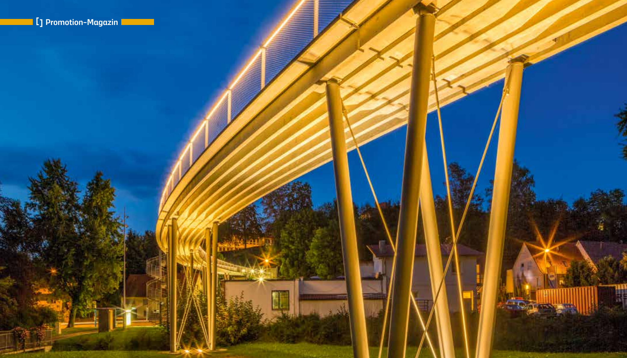
Fußgängerbrücke in Albstadt-Lautlingen: Textilbeton ermöglicht eine spürbare Reduzierung des Primärrohstoffverbrauchs.
