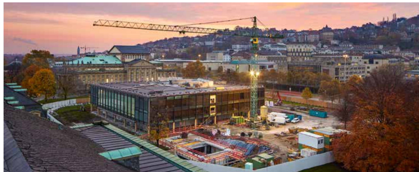
Sanierung des Plenarsaals im „Haus des Landtags“ in Stuttgart
