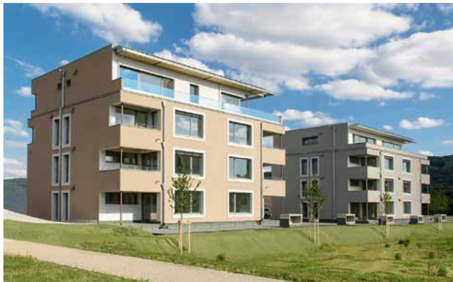
Viergeschossige Mehrfamilienwohnhäuser im Lauchringer Riedpark: Ausschließlich gebaut mit ökologischem Wärmedämmverbundsystem von GUTEX Thermowall und Lignotrend-Bauteilen.
