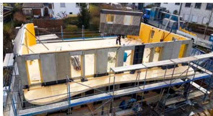
Digital vorgefertigte Bauelemente ermöglichen eine schnelle Montage.
