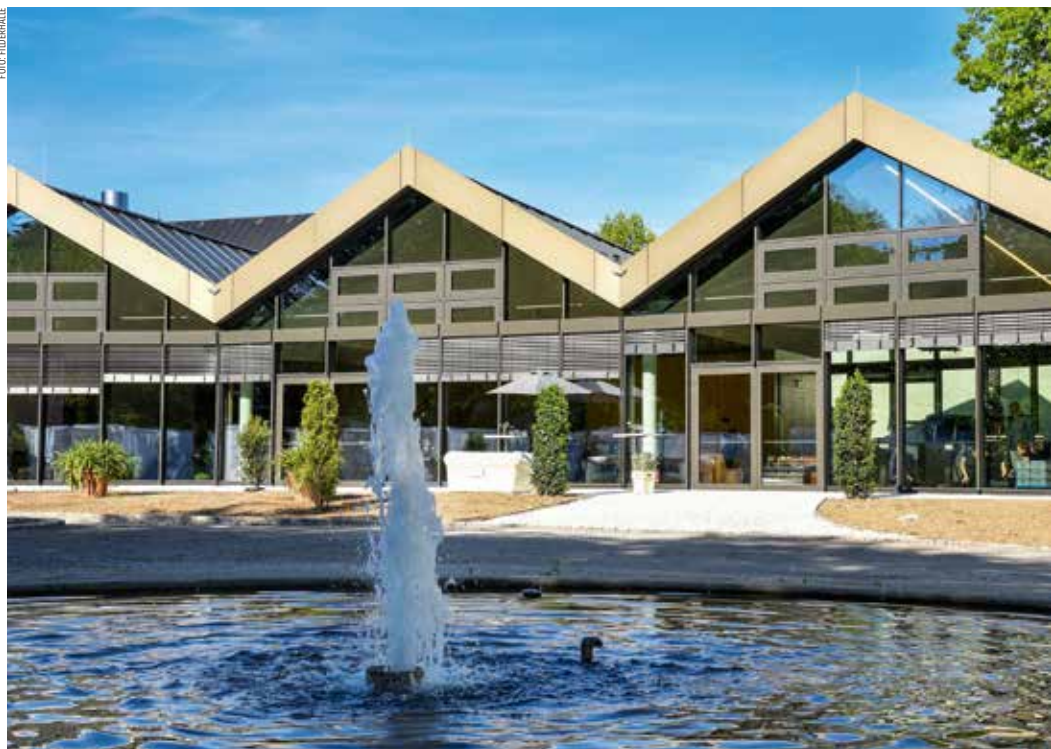
Die Filderhalle präsentiert sich außen mit neuem Zubau und innen digital aufgerüstet.
