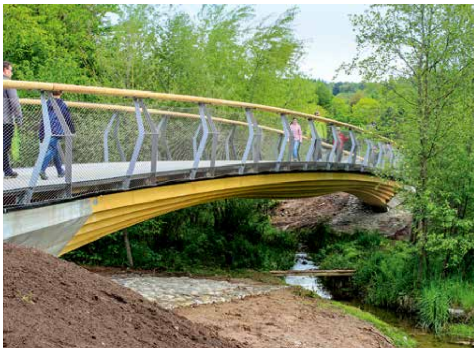
Im Remstal wurden vor Kurzem die weltweit ersten Massivholzbrücken in integraler Konstruktionsweise realisiert.
