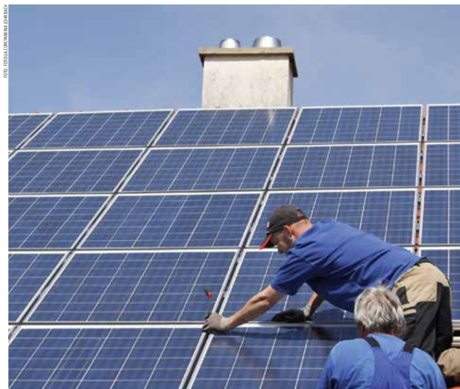
Installation einer großen Photovoltaik-Hausdachanlage
