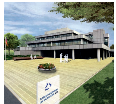
Das neue Ausbildungszentrum der Bauindustrie NRW in Oberhausen wird 2018 den Betrieb aufnehmen.
