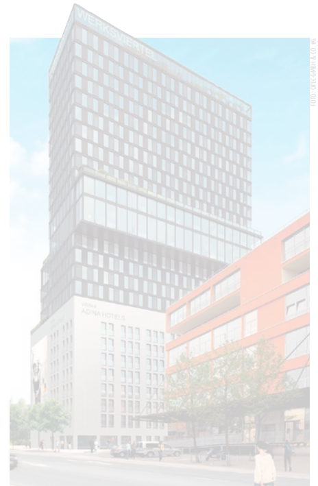
Im Werksviertel am Münchner Ostbahnhof entsteht ein Vorzeigeprojekt moderner Städteplanung.
